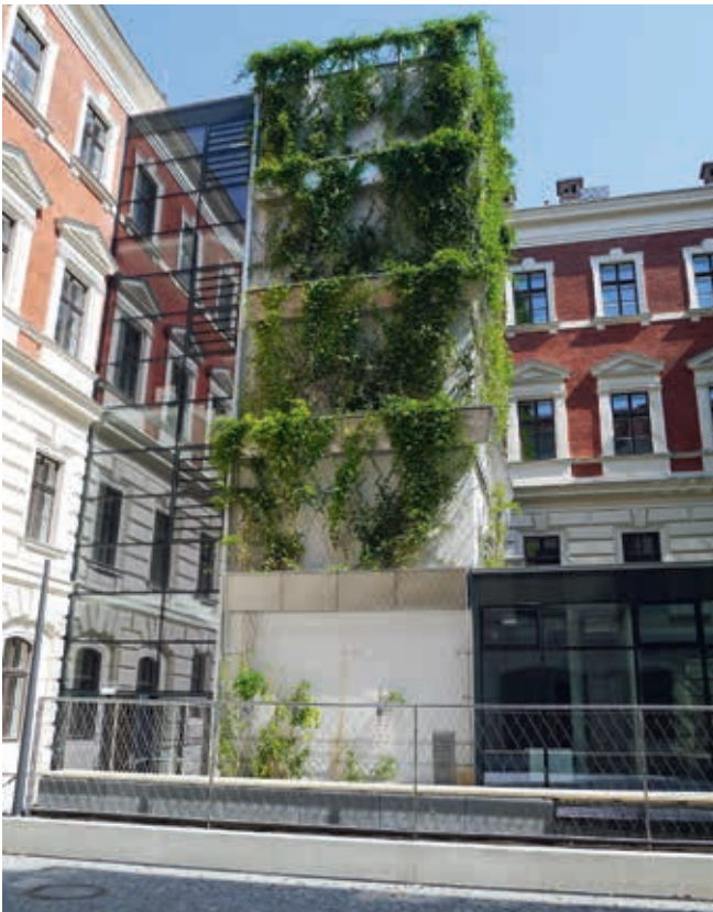
Der neue Innenhof
